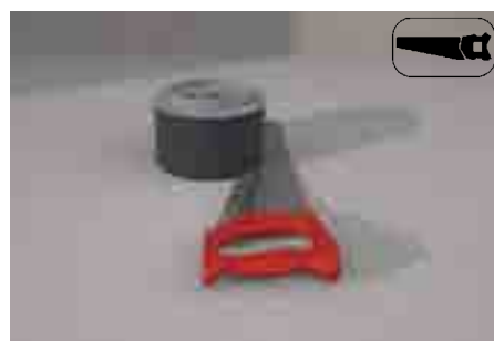
5. Az aljzatbeton megkötése után a felesleges nyakrészt egy fűrészsel az aljzat szintjénél levágjuk.
