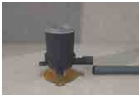
1. A furatjelölő sablont a becsövezés irányába állítva a furatok helyét bejelöljük.
