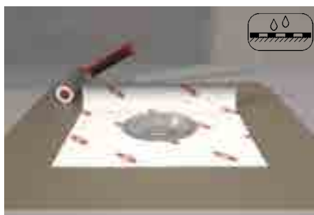
7. Az aljzatbetont a bevonatszigeteléssel a gallér alatt, majd a gallér lesimítása után annak felszínét is bevonjuk (szendvics-szerűen). A zuhanytér hajlatainál javasolt hajlateralósító szalagot használni.
