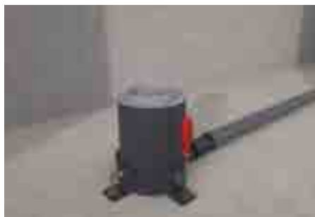
2. A jelölt furatokat elkészítjük és a lefolyótestet a rögzítő talpakkal, dübelekkkel és csavarokkal a szerelőbetonra rögzítjük.
